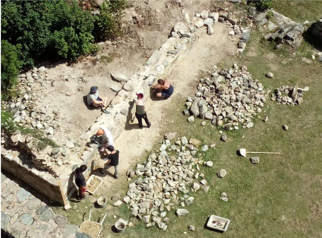
Les bénévoles jointoient les pierres au mortier de chaux
