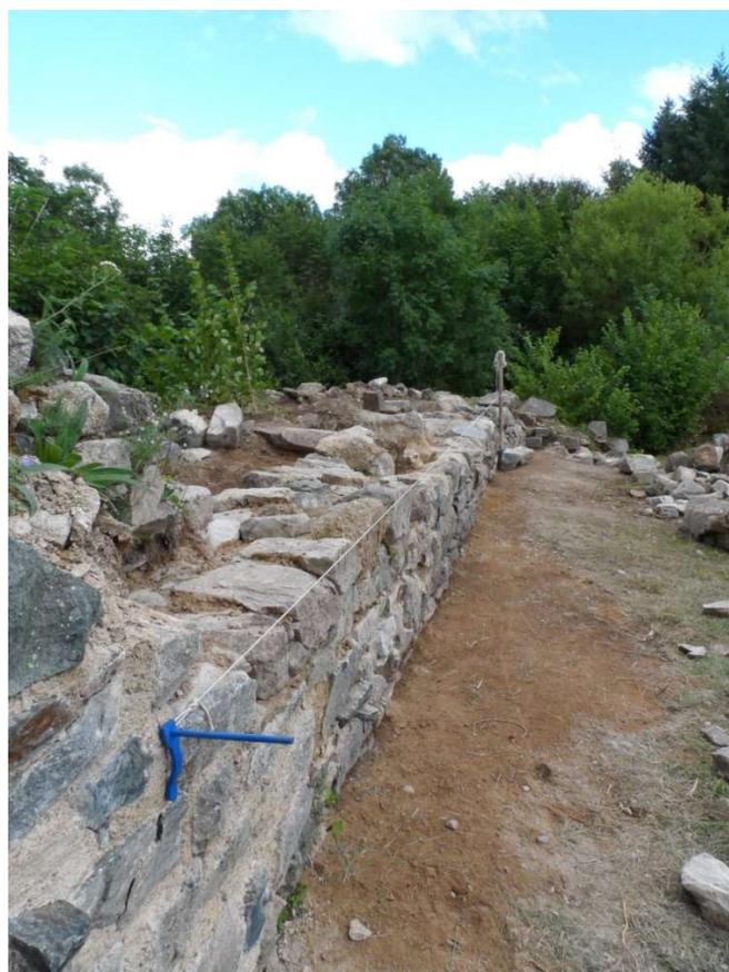
Maçonnerie de moellons pour remonter le mur
